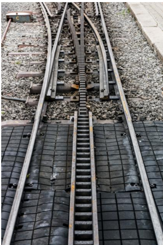
Loken tuggar sig fram längs kuggstängerna mellan skenorna.
