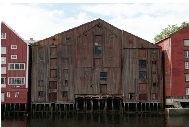
"Med ett visst renoveringsbehov"
