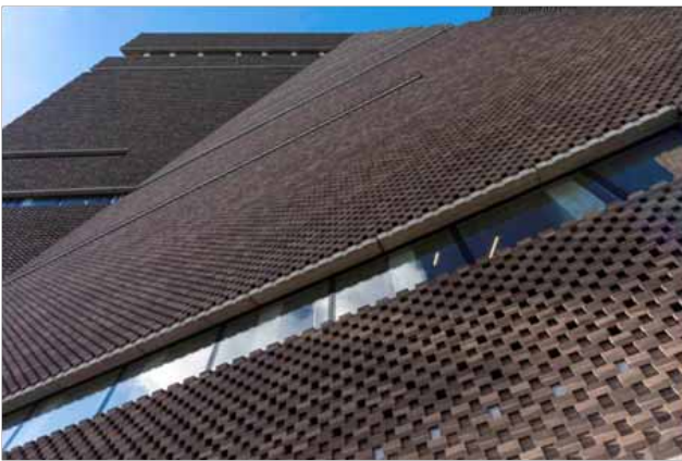
Del av fasaden på Switch House
