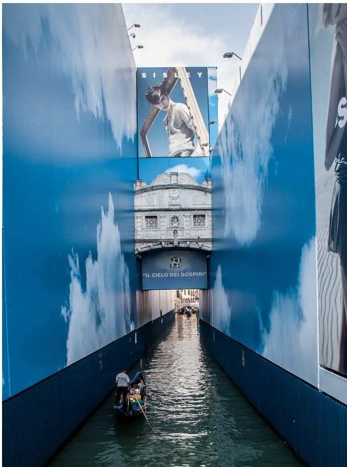
Suckarnas bro, Dodgepalatset, Venedig. Fasadrenovering pågår, där av den märkliga väggbeklädnaden.
