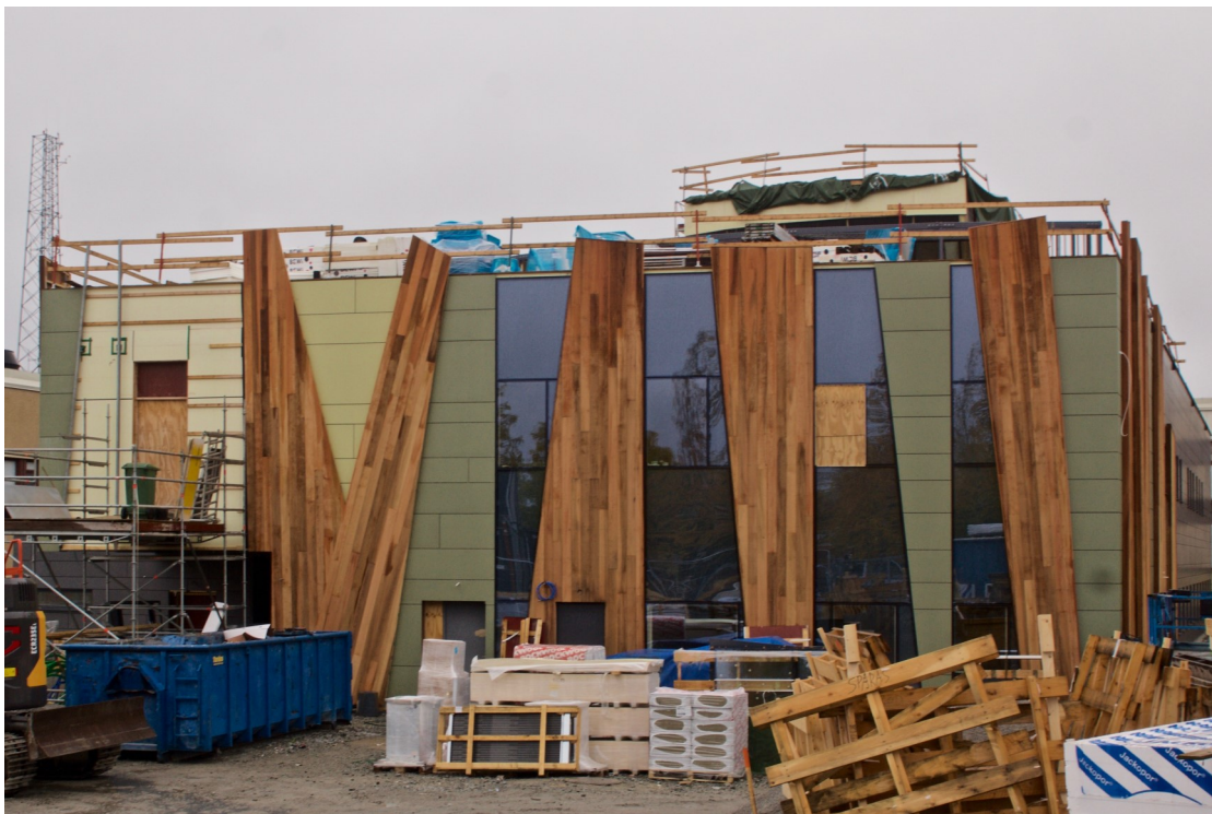
Så här såg det ut för en tid sedan vid bygget av Östersunds nya häkte. Intressant fasadbeklädnad. Ska bli intressant att se hur slutresultatet blir
